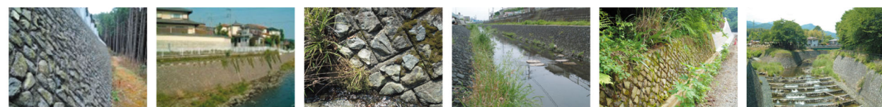
①明度3から6 ②彩度を制御 ③テクスチャー ④水際への配慮 ⑤生態系の基盤 ⑥天端が目立たない
