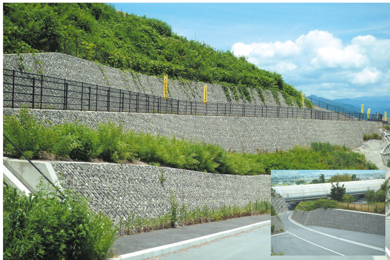
山梨県リニアモーターカー関連工事
