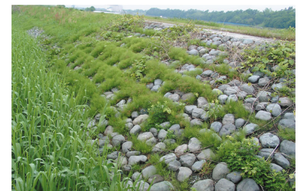
福島県 支川 釈迦堂川右岸地区工事
