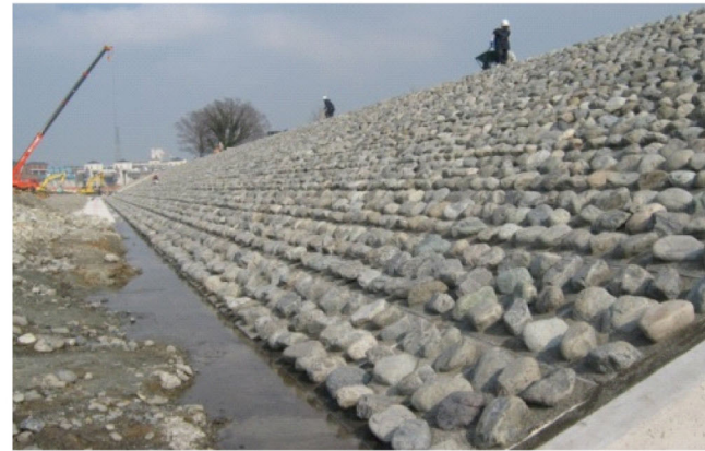
国土交通省 荒川上流工事事務所 畠山護岸
