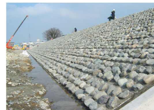
国土交通省 荒川上流工事事務所 島山護岸
