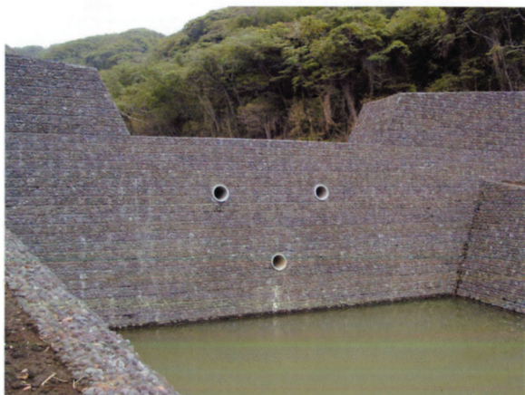
三宅島砂防ダム サステイナパネル
