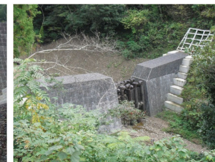
千葉県 合戸砂防堰堤
