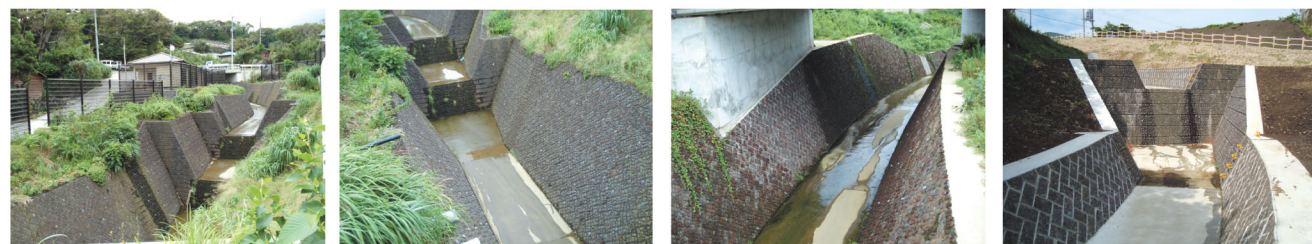
三宅島 島内の流路工 溶岩ブロック
