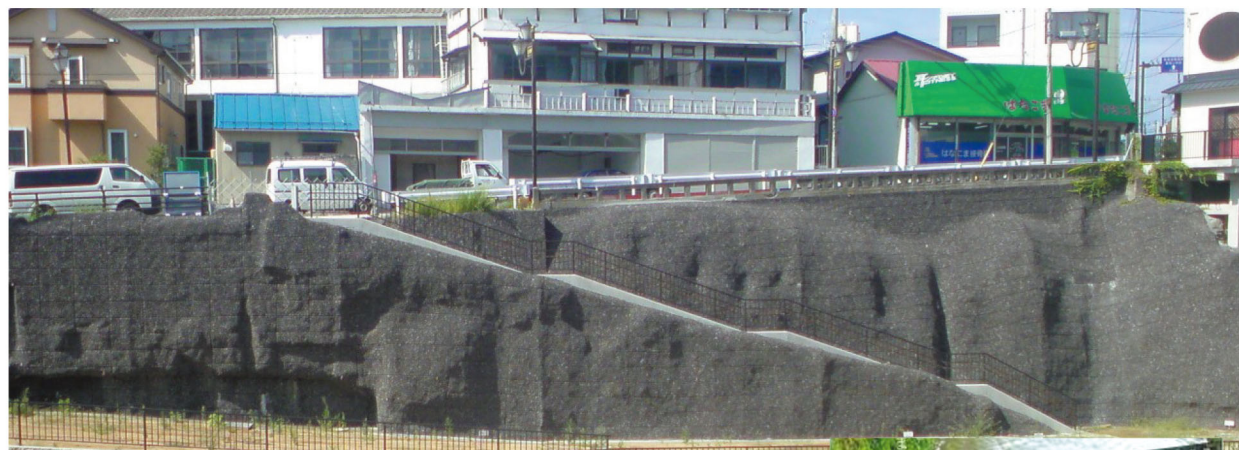
福島県 飯坂温泉吹付法面補修景工事
