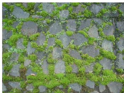
施工6年後の経年変化
