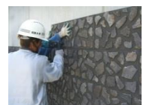
パネル取付け
