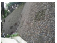
ビオフィーム施工直後
