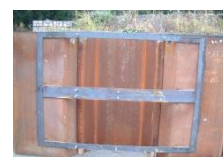
フレーム溶接
