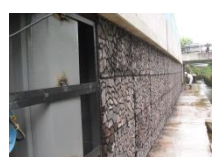
パネル取り付け
