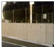
コンクリート構造物
