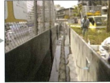
ドレーンパイプを通す
