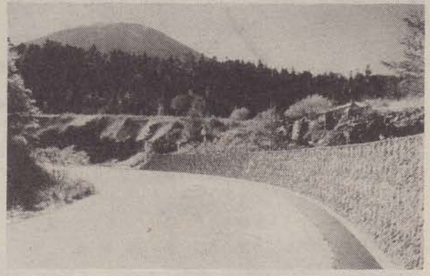
製品の施工例で、富士箱根伊豆国立公園内の道路擁壁に使用された例。溶岩を用いているため、富士山(火山)と調和がとれている。
