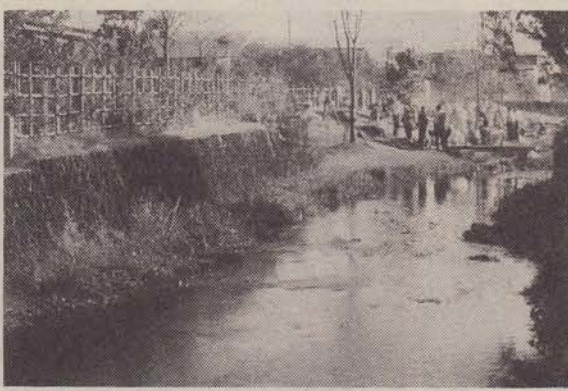
河川に使用された例。ブロックの表面の天然溶岩が落ち着いた風景を作り出している。
