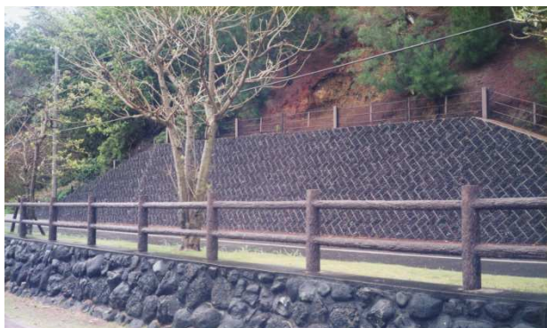
父島 多孔質溶岩ブロック
