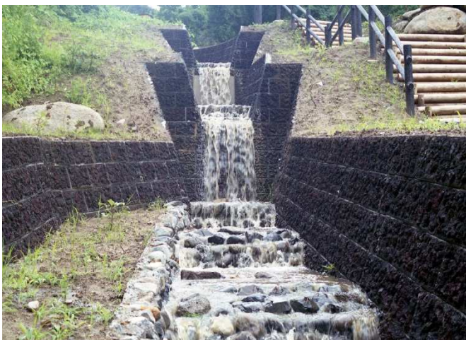
山梨県 山梨市 岩手地区ほたる水路 多孔質溶岩ブロック
