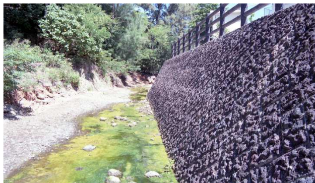
父島 多孔質溶岩ブロック
