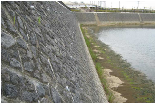
埼玉県三郷市調整池 多孔質溶岩ブロック雑割
