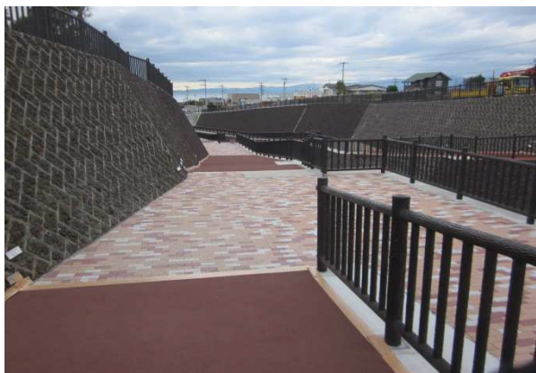
大島 多孔質溶岩ブロック
