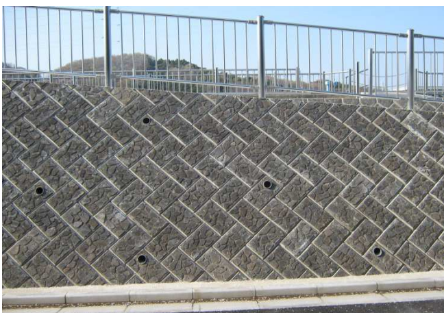
神奈川県 相模原市 谷ヶ原浄水場
