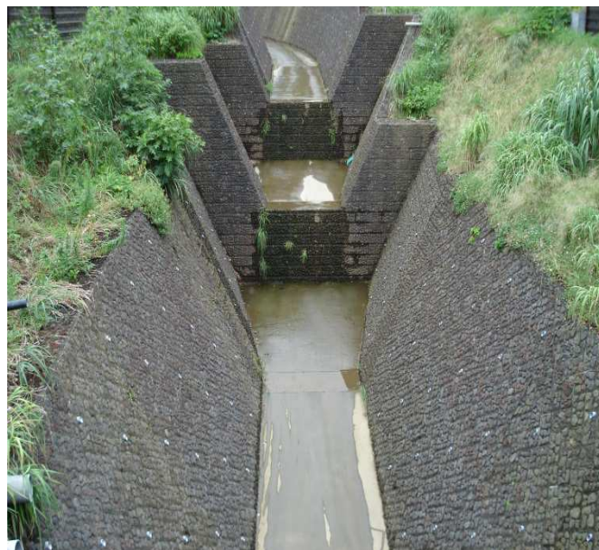
東京都 三宅島 多孔質溶岩ブロック
