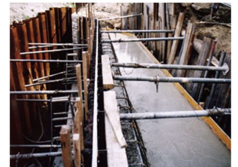
⑥天端コンクリートの打設
