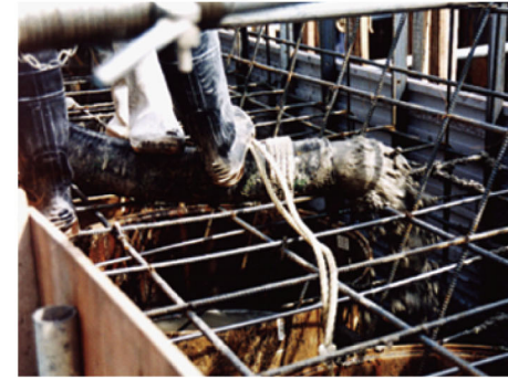
⑤鋼管とパネルの中にコンクリート打設
