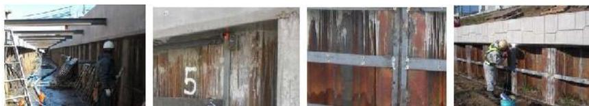
①施工面の清掃 ②位置決め ③10mm目地 ④溶接
