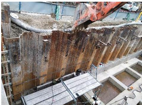
④鋼矢板の前面に製品を配置し、背後にセパレーター、異形鉄筋を用いて溶接固定する。
