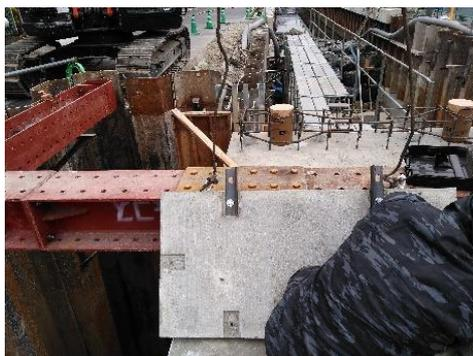
②製品に縦横連結金具を取り付ける。
