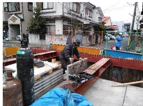
③製品の吊上げは、上部の連結金具を用いて吊上げる。
