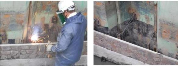
上記の工程を繰り返し行い、3段を目安にコンクリートを打設する。コンクリートを打設する際に上段縦接続アングルまで埋めないように注意する。上記の作業を繰り返し行う。
