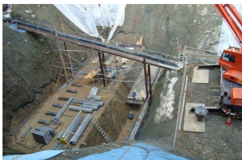
1. 砂防工事現場
