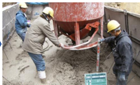
5. コンクリート打設
