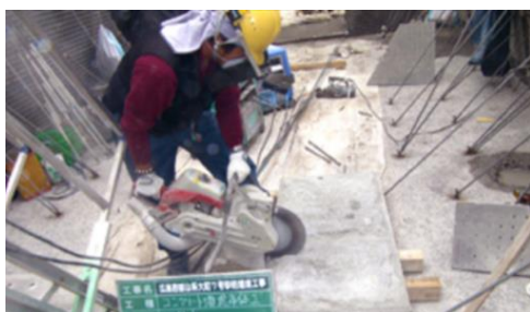
4. 残存型枠切断加工状況
