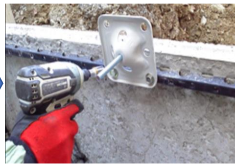
3. 専用組立部材取付状況
