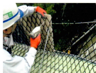
②ボルトナットでパネルを固定
