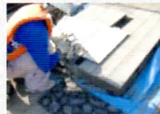
コンクリートカッターで切断可能
