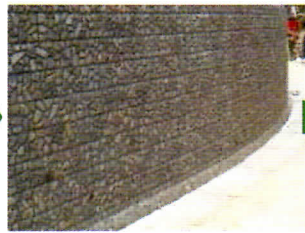
パネル設置後
