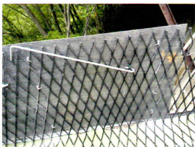
③固定されたパネル裏面
