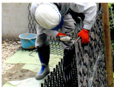
①補強土擁壁に合わせて穴をあける
